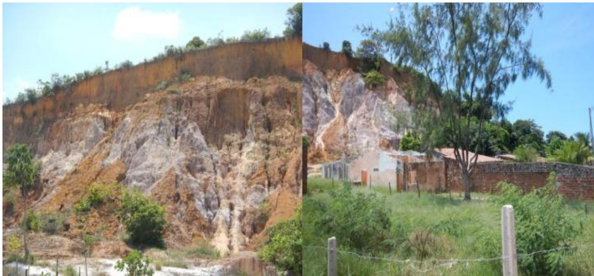
Figura 5 - Setor Alto do Pôr do Sol, região com risco alto ao deslizamento.
