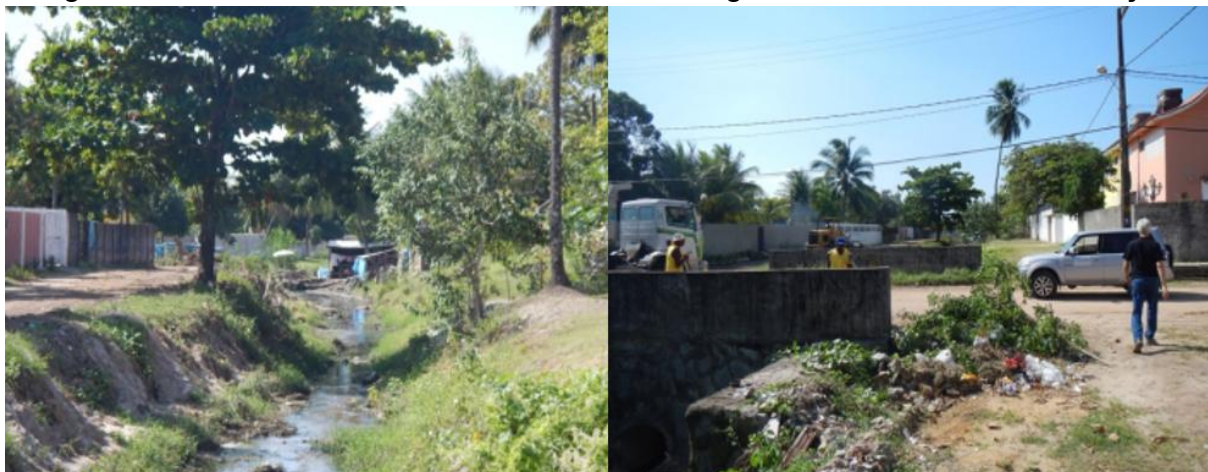
Figura 9 - Setor Rua Colômbia, Bairro Centro, região com risco alto à inundação.
